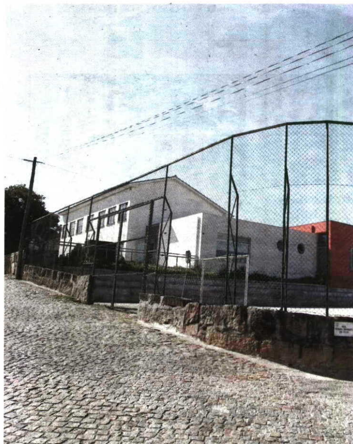
Construção e remodelação da Escola de Fontelete são algumas das obras em causa
